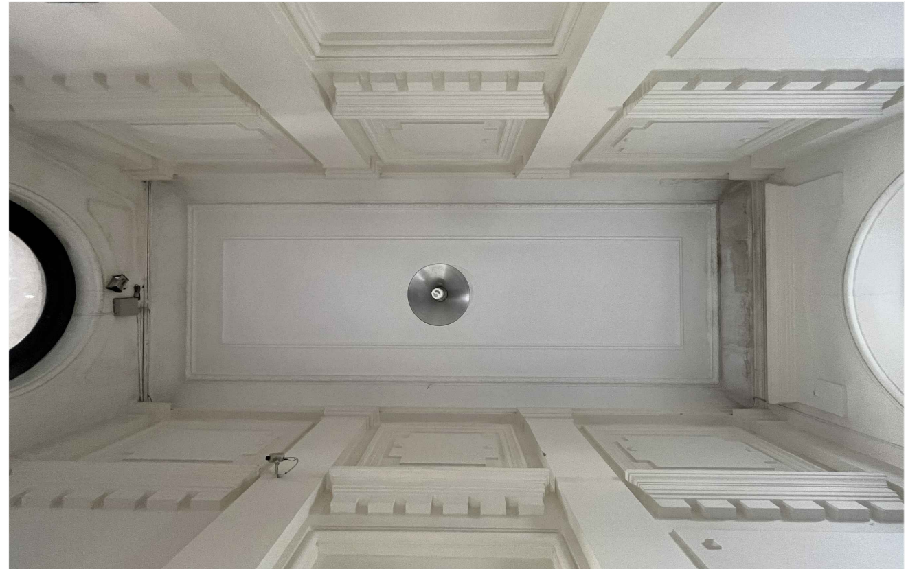
FOTO DEL CIELORRASO
