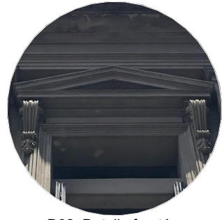
D02 Detalle frontón triangular y ménsulas
