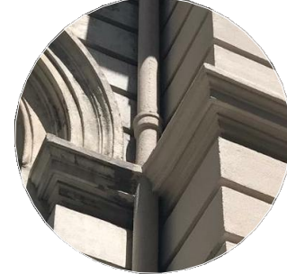
D03 Detalle caño de bajada
