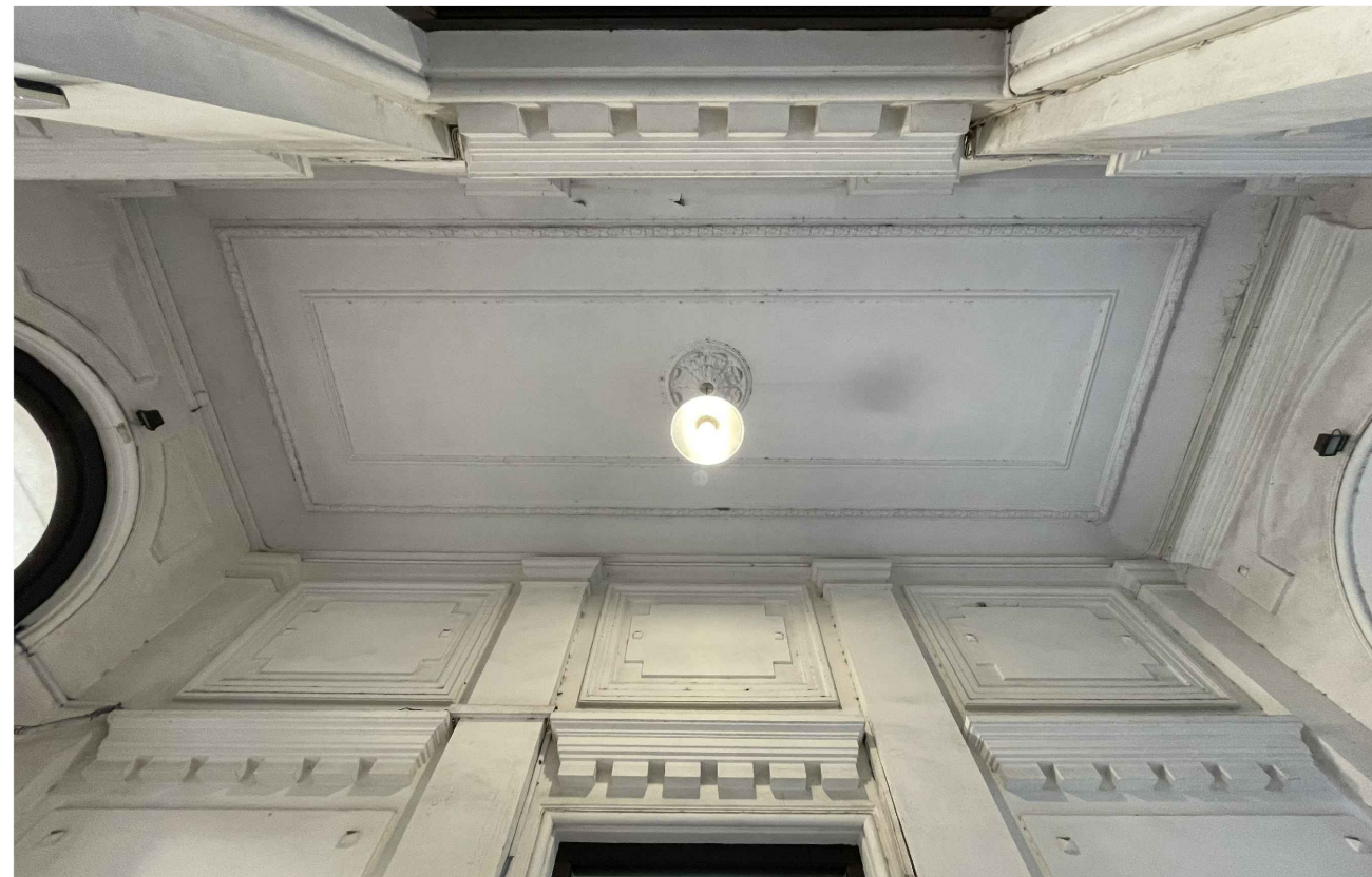
FOTO DEL CIELORRASO
