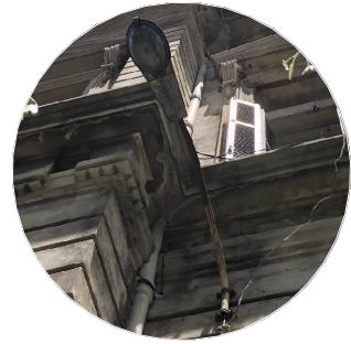
D01 Detalle cornisa inferior, elementos a retirar y caño de bajada
