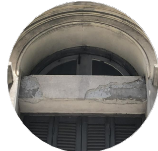
D04 Detalle dintel de hormigón
