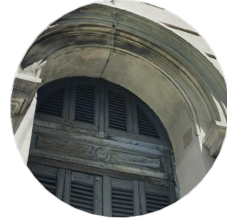
Detalle abertura con postigones y arco medio punto
