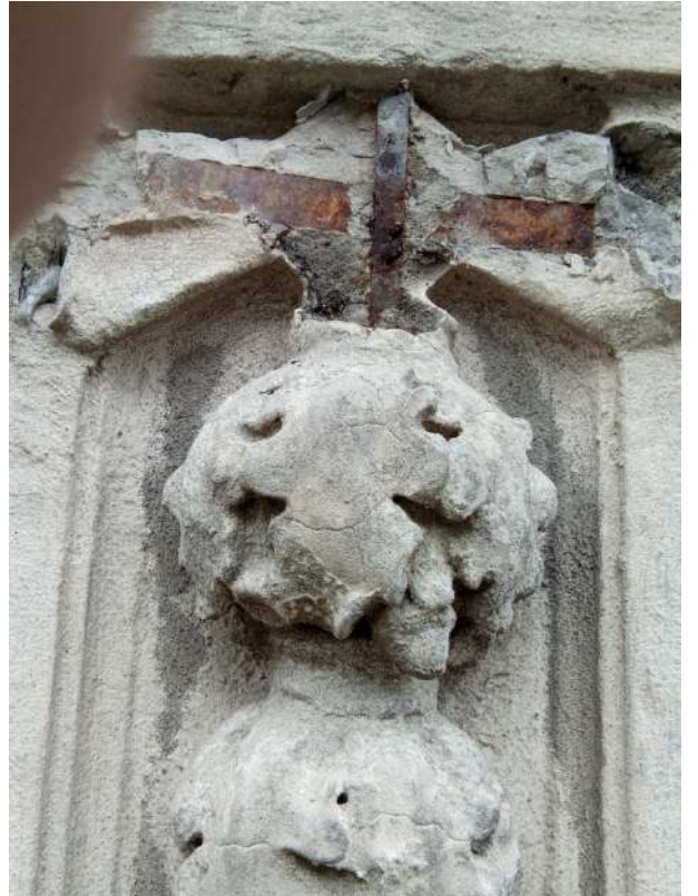
Rotura en moldura
