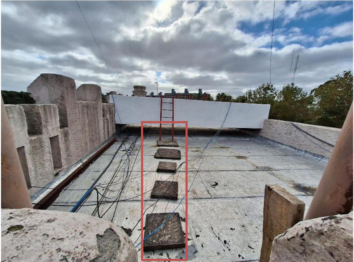
*-En el sector de la torre donde se encuentra el tanque se deberá colocar caminero ancho 0.50m de membrana mineralizada.*
