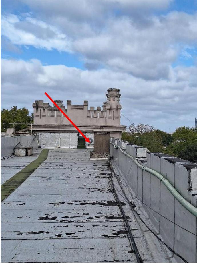
*-Con respecto a la chimenea que se encuentra en el sector, se solicitara se reparen sus fisuras de la misma forma que se menciono para la situación anterior y revoques para luego se impermeabilicé.*
